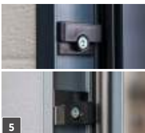
5 System zapobiegający opadnięciu skrzydła.
